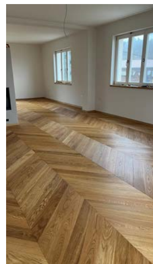
Dieses Privathaus in Arberg stattete der Betrieb mit 150 m 2 Eichenparkett von Mefo Floors aus, verlegt im Französischen Fischgrätmuster (Chevron).
